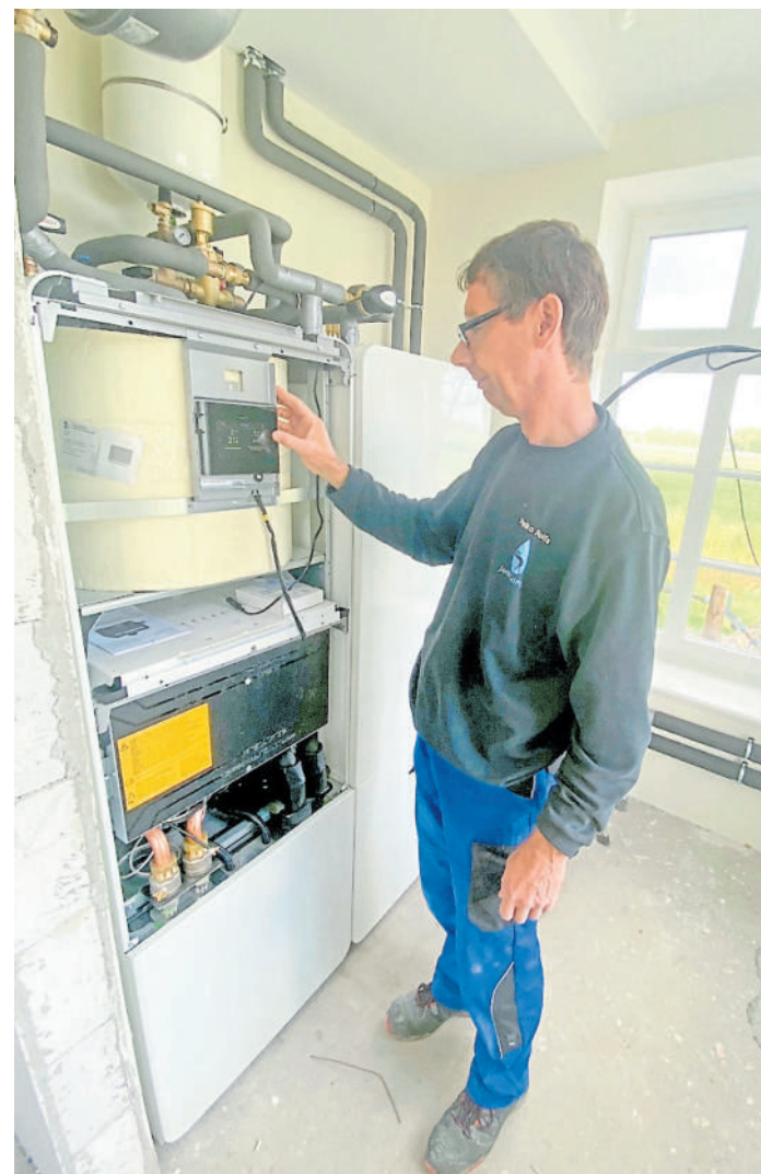
Heiko Rolfs bei der technischen Einstellung einer Solewärmepumpe in Hohenkirchen.
