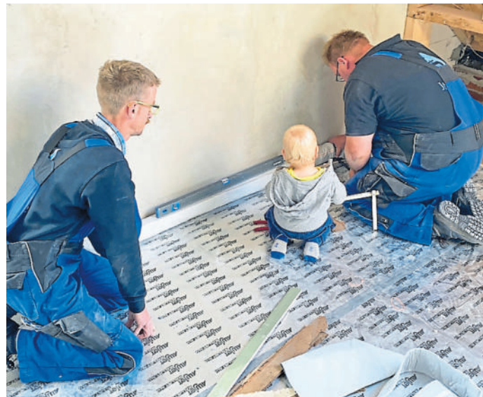
Andreas Janssen, Junior Bente Schulze und Jann Caspers bei der Verlegung einer Abflussleitung in Hohenkirchen. BILD: SCHULZE
